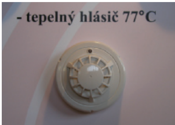
Tepelný hlásič
