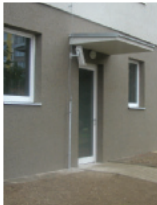
Kamera u zadního vchodu do objektu
