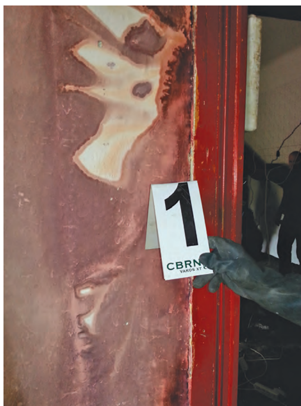
Obr. 3: Depozice sublimovaného jodu do omítky; původní barva malby je žlutá (Zdroj: VAKOS XT)
