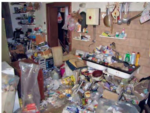
obr. 4 – Kuchyně před začátkem prací (zdroj Dekonta a. s.)
