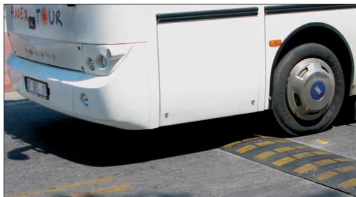
Zklidnění silničního provozu – příčné prahy
