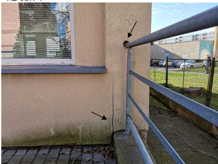
obr. 5 SZ roh objektu s pokleslou rampou
