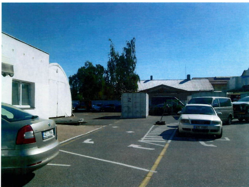
Vytvořený přechod pro chodce – podél ÚK, včetně parkovacích stání na obousměrné ÚK a vytvoření „jízdního pruhu obousměrného“ s vyznačením šipkami směru jízdy
