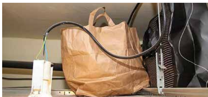
▼ Dózy s prekurzory byly ukryté ve vzduchotechnice
